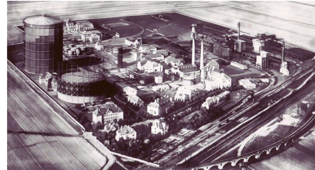
Das Gaswerk Leopoldau war ein weiterer Schritt zur unabhängigen Energieversorgung Wiens
