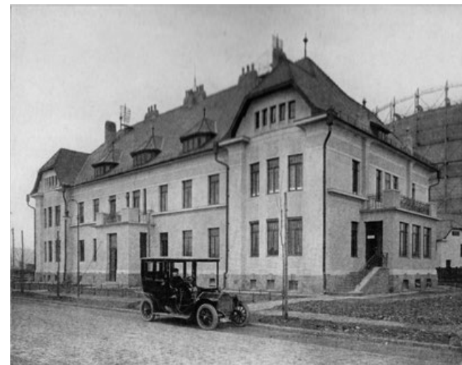
Im November 1911 ging das Gaswerk in Vollbetrieb
