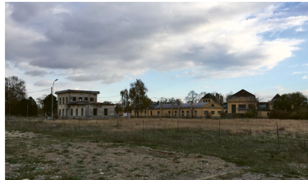
Das so genannte Trafohaus vor der Sanierung und Umnutzung zum Grätzzentrum
